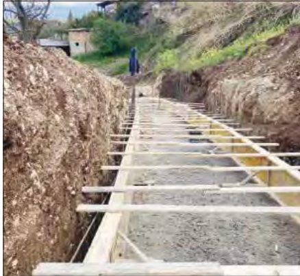
I lavori di regimentazione delle acque proseguono senza sosta
