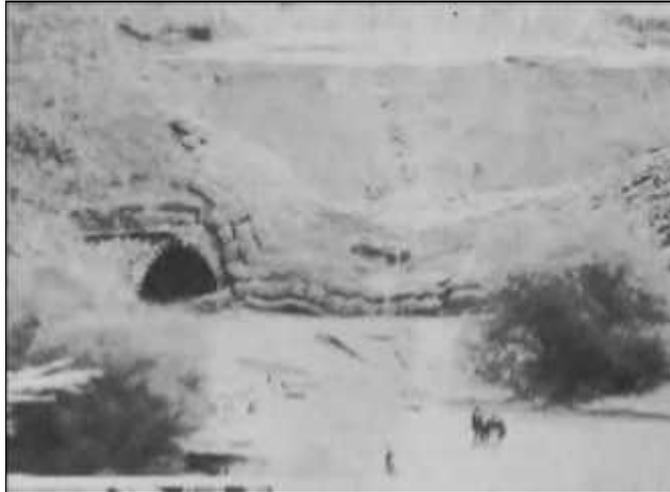
*Figura 75. Catanzaro, frana presso la galleria della ferrovia Catanzaro-Lametia (R82-1987).*
