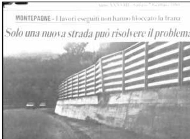
*Figura 89. Montepaone, il muro e la barriera danneggiati dalla frana (R1-1989).*
